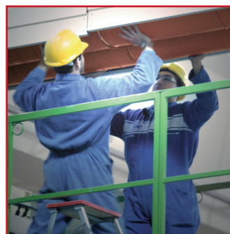
Staff tecnico di montaggio
