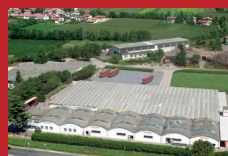
Training center, produzione scambiatori radianti Via Sile, 17
