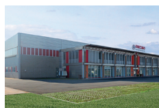
Headquarters, R&D, produzione gruppi termici e soffitti radianti Via Sile, 48
